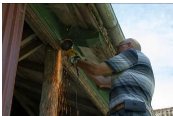
Køreskinne til nordvestligste stålport fjernes af Henrik Persson.
