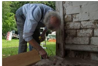
Gammelt tømmer udskiftes med nyt og tappes efter den gamle metode. Axel Dolleris i arbejde.
