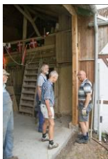
Den nye stolpe med 3 taphuller. Axel, Jens Johan, Henrik og Carsten Roug besigtiger.
