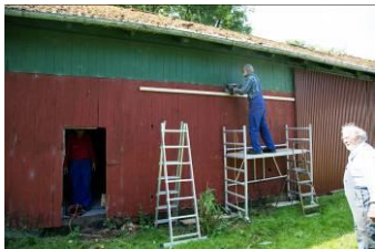
Nordfacade udskiftes, 4 juli 2013. Jens Johan Dahlkild og Axel Dolleris i arbejde.
