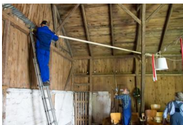
Afstivning for stabilisering af østgavl, 19. august 2013. Henrik Persson, Jens Johan Dahlkild og Axel Dolleris.
